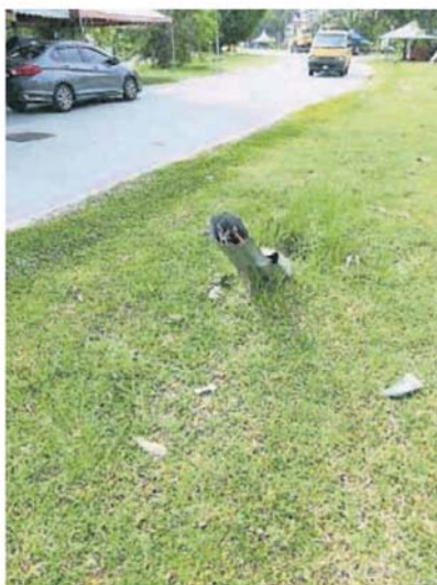
■整支街灯被撞断。
