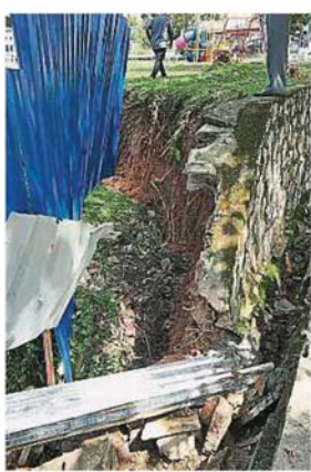
▲工地与排屋中间的小巷裂出长长的裂缝，让居民担忧地基受到影响。
